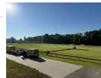
Realizace aut. zavlažování fotbalového hřiště
