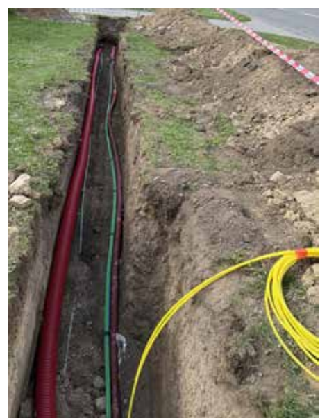
Rekonstrukce elektrorozvodů veřejného osvětlení a obnova rozvodů nízkého napětí v ul. Dědina
