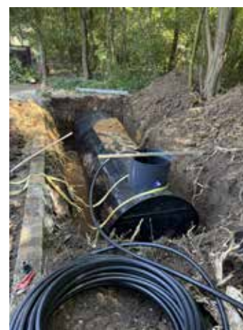
Realizace aut. zavlažování fotbalového hřiště - nádrž
